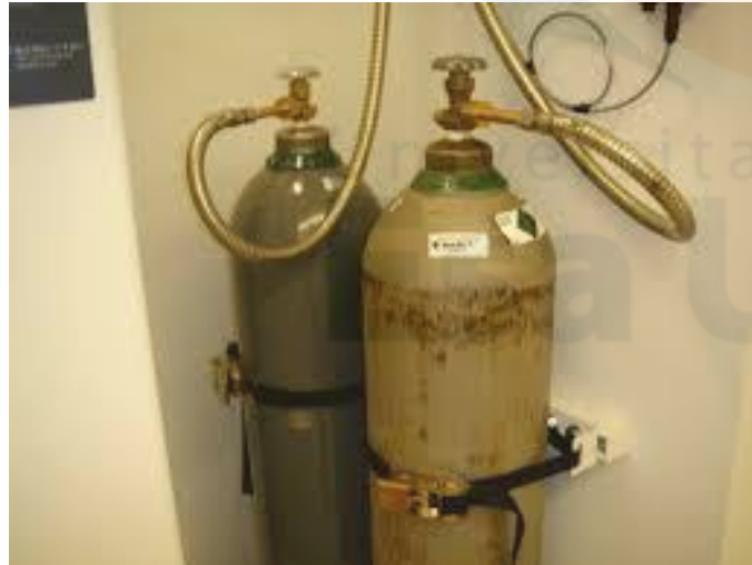
Gambar 6. Rantai atau pengaman tertentu diletakkan di sekeliling tabung untuk menghindari tabung terjatuh.
